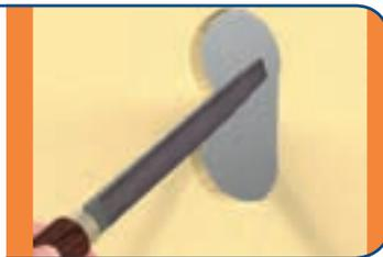
**4** Antes de colocar la caja eléctrica en la abertura de la placa, se debe romper el número necesario de entradas para los conductos. Con una navaja, corte la unión de entrada.
