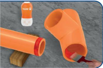
**3** Por último, vuelva a sumergir el pincel en el adhesivo Aquatherm® TIGRE y vuelva a aplicarlo en la punta del tubo donde ya se había aplicado el adhesivo en el paso 1 y encaje en la conexión. No es necesario en este caso girar 1/4 de vuelta.
