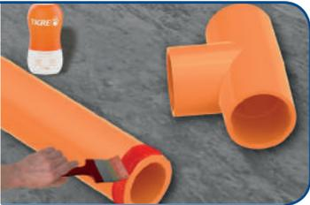
**2** Vuelva a sumergir el pincel en el Adhesivo Aquatherm® TIGRE y aplíquelo a la bolsa de conexión.
