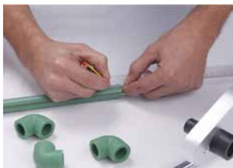
4. Realizar una marca de profundidad de inserción en el caño conforme a la medida indicada por la tabla para cada diámetro. Ver tabla 2.
