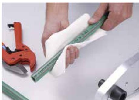
3. La limpieza del tubo antes de introducirlo en las boquillas garantiza la duración de las mismas.
