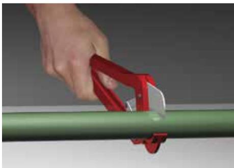
Corte los tubos con herramientas Fusión Tigre afiladas así se obtendrán cortes rectos y sin ovalización.
