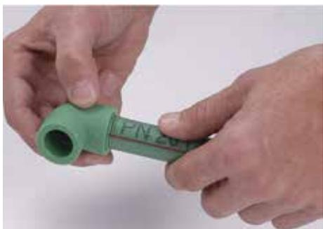
9. Detenga la introducción del caño en el accesorio cuando los dos anillos visibles que se forman por el corrimiento del material se hayan unido.
