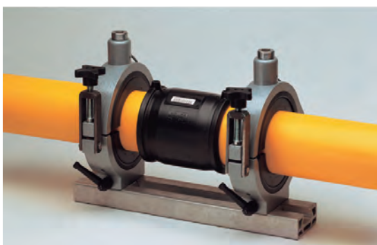
Paso 5: para el tubo opuesto realizar los pasos anteriores y montar en el accesorio. La zona que se va a soldar debe permanecer estable e inmóvil.
