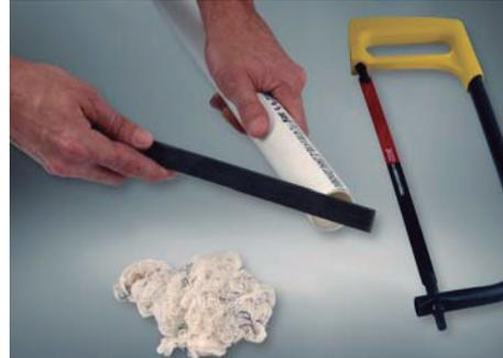
2. Desbarbar los cantos de corte. Biselar los extremos del tubo con un ángulo de aprox.15°, utilizando una herramienta de biselar o una lima.
