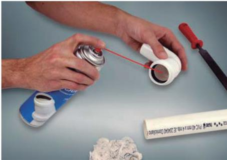
3. Limpiar la junta de estanqueidad, el interior de la campana y la espiga. Aplicar solución lubricante sobre el o'ring y la espiga del tubo.
