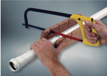
1. Cuando sea necesario, cortar los tubos con una sierra de dentado fino. La utilización de una caja de corte permite realizar un corte perpendicular.
