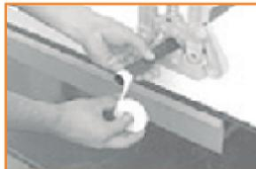
**Paso 4:** Hacer la limpieza del tubo y aplicar Cinta Teflón TIGRE sobre los filetes en el sentido de la rosca de tal modo que cada vuelta traspase a la otra en 1/2m en un total de 3 a 4 vueltas.
