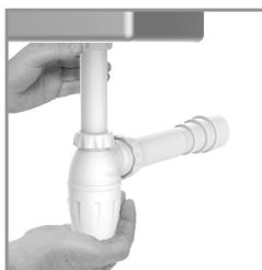
**Paso 2:** Ajuste el tubo de entrada vertical a la posición de la tubería de desagüe y atornille la tuerca del sifón.
