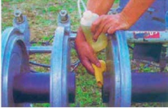
**Paso 4.** Limpiar la superficie con la solución a base de alcohol y a partir de ese instante evite tocar la región a ser soldada.
