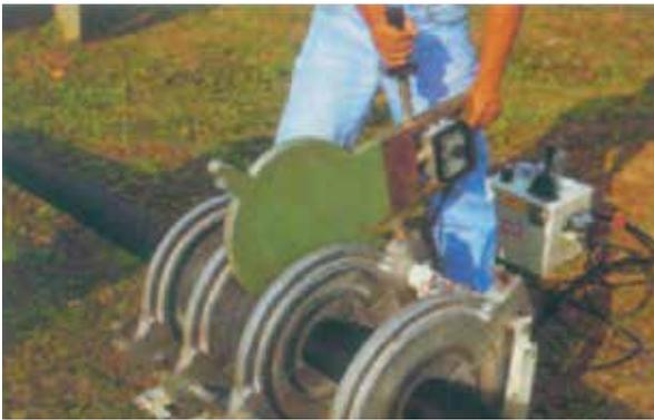
**Paso 6.** Retire la placa calentadora y aproxime los tubos. El cordón de soldadura aumentará de dimensión. Aguarde el enfriamiento recomendado por el fabricante del equipo.
