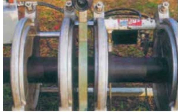
**Paso 5.** Cuando la temperatura de la placa calentadora llegue al valor recomendado por el fabricante, posicónela manteniendo la presión de soldadura hasta la formación de un cordón inicial entre la placa y el tubo (la tabla suministrada de la máquina indicará la dimensión del cordón).
