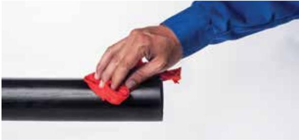
**Paso 1.** Limpie muy bien y seque el extremo de la tubería.
