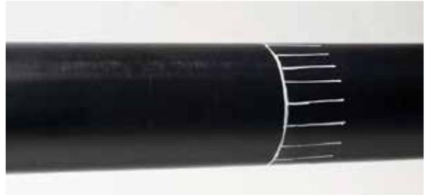
**Paso 2.** Marque primeramente la longitud del tubo a introducirse en el accesorio, luego marque el área del tubo que se va a raspar trazando líneas visibles y perpendiculares al raspado.
