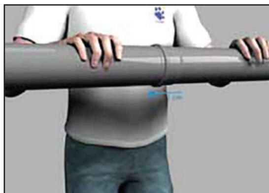
5- Previsión de huelgo o espacio para movimientos de la cañería: marcar la profundidad máxima de la campana en el extremo macho del tubo e introducir el mismo alineado y hasta al menos 2 cm antes de llegar a dicha marca, para que quede un espacio que permita absorber los movimientos que pueda tener el conjunto.
