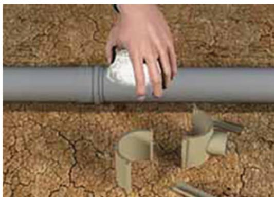
1- Limpiar con una estopa húmeda el tubo donde se va a efectuar la abrazadera.
