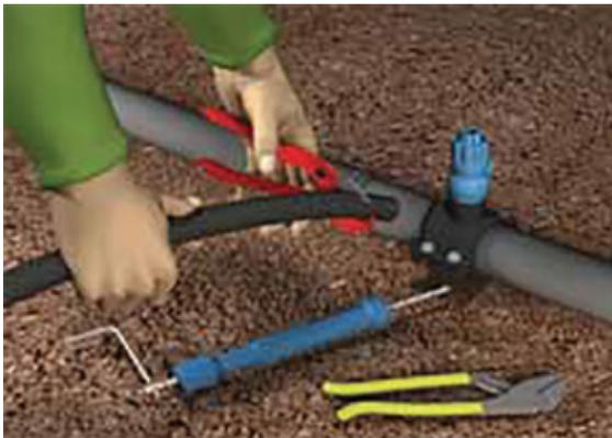
3- Con el cortador de tubos, acertar el corte de las extremidades del tubo de polietileno (Pe) a ser instalado.
