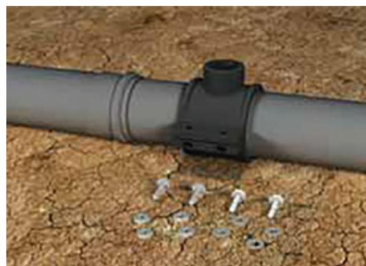
2- Colocar correctamente la abrazadera a instalar.
