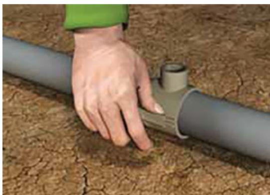
3- Colocar la parte superior (derivación) de la abrazadera con cuidado de poner correctamente el anillo. Tal procedimiento garantiza una unión perfecta. Verificar que los puntos de fijación están encajados en las hendiduras. Inmediatamente después colocar las trabas, paralelas, ambas en el sentido de fijación.
