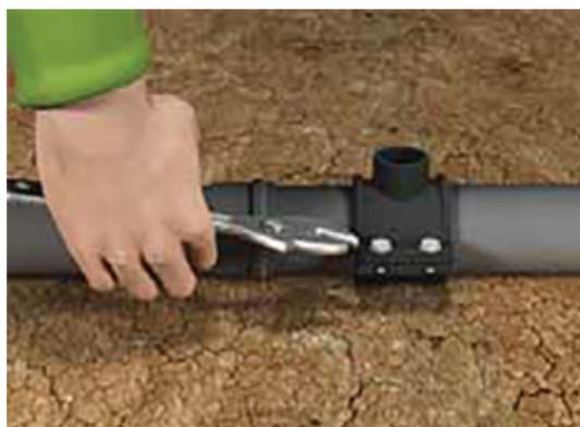
3- Colocar los tornillos, luego las tuercas, alternando entre un lado y otro. El exceso de fuerza puede producir la deformación del tubo.
