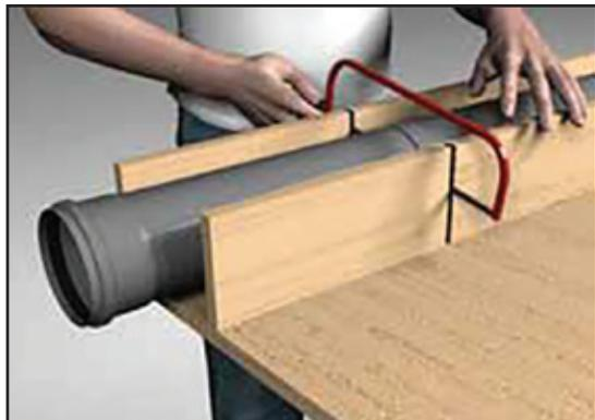
1- Corte de tubos. Para obtener un corte a 90° preciso, se sugiere el empleo de una guía.
