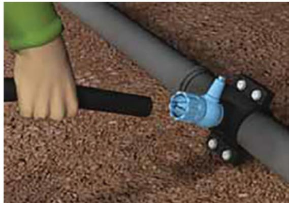
4- Colocar el cónico y la punta del registro (dejar flojo), e introducir el tubo de polietileno en el adaptador, verificando si el mismo apoyó en el marco.
