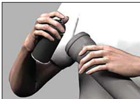
4- Se debe aplicar pasta lubricante TIGRE sobre la guarnición elastomérica de manera uniforme. Utilizar solamente la pasta lubricante TIGRE.
