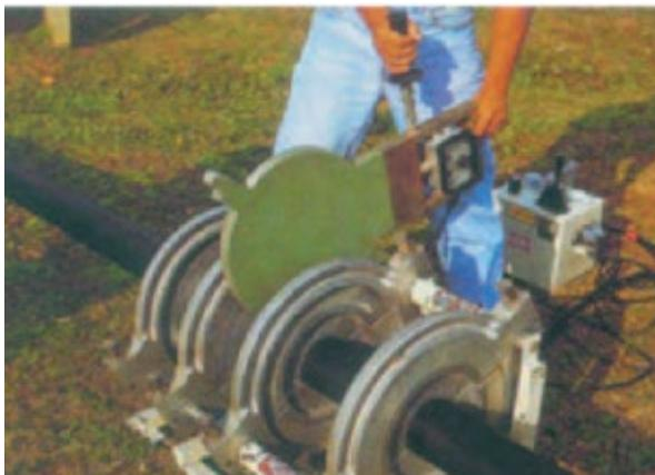
**Paso 6.** Retire la placa calentadora y aproxime los tubos. El cordón de soldadura aumentará de dimensión. Aguarde el enfriamiento recomendado por el fabricante del equipo.
