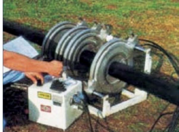
**Paso 1.** A partir de la tabla entregada por el fabricante, verifique la presión de soldadura requerida y súmela a la presión inicial para desplazamiento (inercia de la máquina más el peso propio del tubo a ser desplazado).
