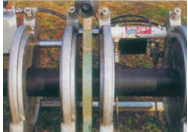
**Paso 5.** Cuando la temperatura de la placa calentadora llegue al valor recomendado por el fabricante, posiciónela manteniendo la presión de soldadura hasta la formación de un cordón inicial entre la placa y el tubo (la tabla suministrada de la máquina indicará la dimensión del cordón).
