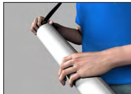
2- La extremidad del tubo cortado debe luego ser prolijamente rebabada y biselada, para facilitar el enchufe. (con lija esmeril, lima escofina o biselador para tubos plásticos).
