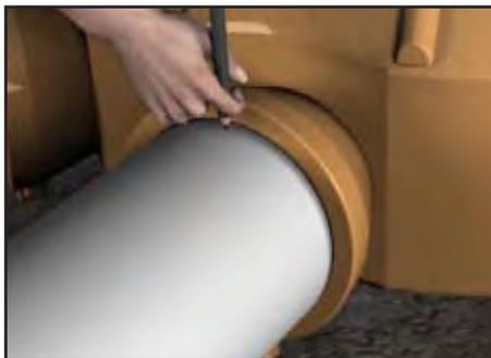
**b) Marcación de tubos:** El nuevo Til Radial posee un batiente interno que limita la profundidad a la que se introduce el tubo. Para garantizar que el tubo sea adecuadamente instalado se debe inicialmente encajar antes que su punta se apoye en el batiente interno. En seguida, se debe hacer una marca en el tubo, el cual servirá como referencia de posicionamiento para el encaje del tubo.
