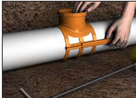
b) Coloque el collar en el tubo fijando con las trabas como muestra la figura.
