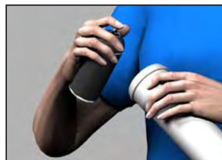
4- Aplicación de solución lubricante o pasta lubricante: Rociar el lubricante sobre la guarnición elastomérica de manera uniforme. Utilizar solamente la solución en aerosol o la pasta, desarrollada a base de siliconas de primera calidad.
