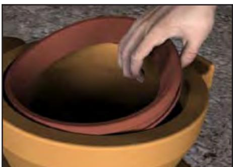
**c) Instalación del anillo:** el anillo con geometría labial debe ser acoplado a la cavidad del Til Radial Tigre, el cual se adapta perfectamente. Además de facilitar el encaje del tubo de PVC Vinilfort, la Junta elástica, garantiza estancamiento contra el vaciamiento e infiltraciones.
