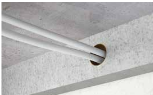
Tubos passando por uma viga
