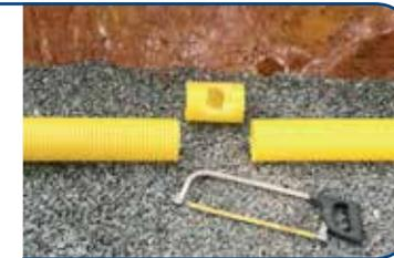
**2** Reemplace el trecho rota con un nuevo segmento de tubería del mismo diámetro, más largo que el segmento cortado. Realice un corte longitudinal en este nuevo segmento de tubería, abra esta ranura y encaje sobre el lugar a reparar.
