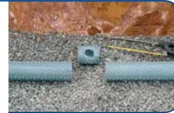
**2** Corte un nuevo segmento de tubería del mismo diámetro, más largo que el segmento cortado. Realizar un corte longitudinal en este nuevo tramo de tubería, abrir esta ranura y encajar sobre el lugar a reparar.
