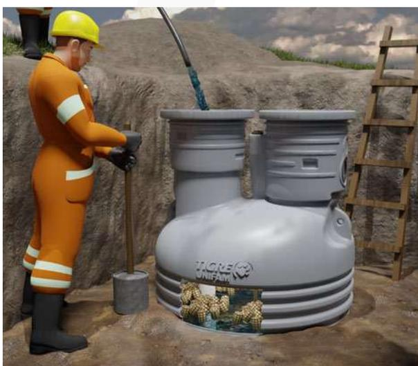
Depois do reaterro chegar a alcançar a metade da profundidade da vala, seguir o procedimento abaixo para instalar as tubulações de saída e entrada do esgoto.
