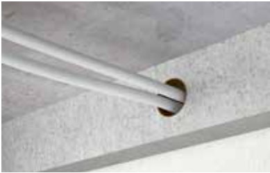
Tubos passando por uma viga
