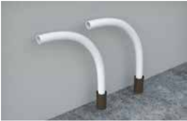
Tubos passando por uma laje
