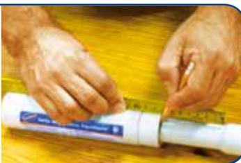
**3** Coloque la Junta de Expansión Aquatherm® TIGRE con el pistón correctamente extendido en el lugar donde se instalará. Haga las marcas de corte de la tubería en los lugares coincidentes con la parte inferior de las bolsas de la Junta de Expansión Aquatherm® TIGRE.
