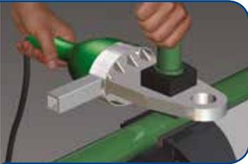
**5** Retire rápidamente el termofusor y presione el sillín durante 30 segundos. A continuación, deje que la junta se enfríe durante 10 minutos.
