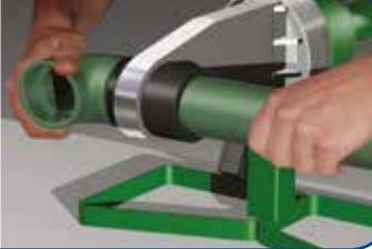
**7** Proceder inmediatamente a la unión. Detenga la introducción de la tubería en la conexión cuando se unan los dos anillos visibles que se deben al movimiento del material.
