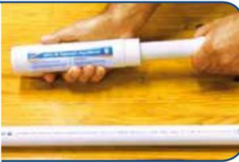
**2** La Junta de Expansión Aquatherm® TIGRE debe instalarse con el pistón parcialmente extendido. Marque la longitud de acuerdo con la ilustración de la posición del pistón y la tabla 3 (también en la Junta de Expansión Aquatherm® TIGRE).
