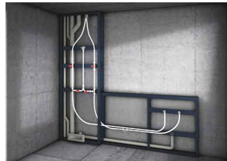
Los kits hidráulicos se pueden usar en diferentes aplicaciones, desde paredes convencionales hasta sistemas drywall.
