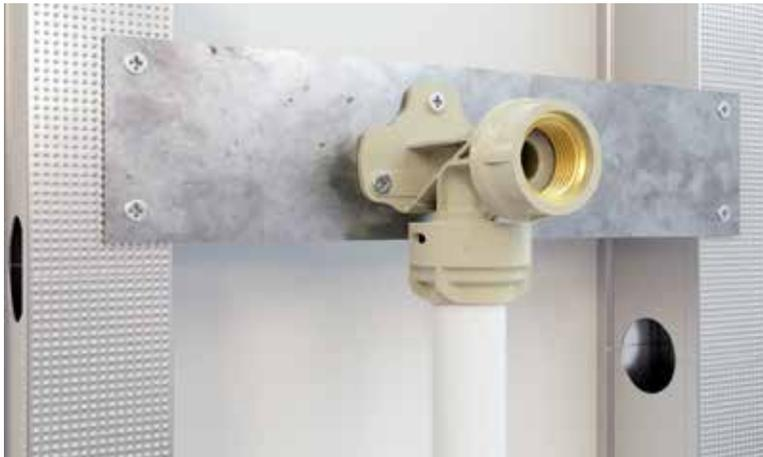
**Obs.:** El codo debe fijarse en el montante con dos conjuntos de tuercas, tornillos y arandelas.
