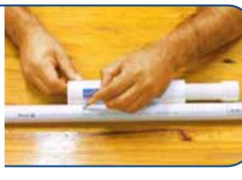
**4** Aplique el Adhesivo Aquatherm® a las bolsas de la Junta de Expansión Aquatherm® e instálela en la sección de tubería horizontal o vertical.
