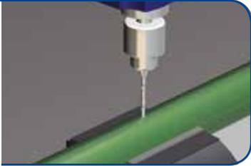
**2** Utilice el taladro con perforador para el sillín de derivación.
