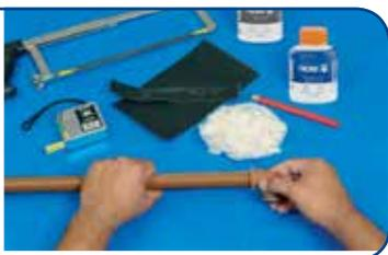
**4** Colocar inmediatamente los extremos a soldar, favoreciendo al mismo tiempo un ligero movimiento de giro de 1/4 de vuelta entre las piezas, hasta que alcancen la posición definitiva. Retire el exceso de adhesivo y espere 1 hora para llenar la tubería de agua y 12 horas para hacer la prueba de presión.
