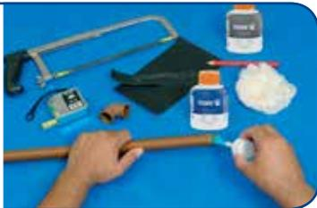
**3** Distribuya uniformemente el adhesivo con un pincel o con la boquilla del propio tubo sobre las bolsas y puntas a soldar. Evite el exceso de adhesivo (siga las recomendaciones presentadas en la tabla 1).
