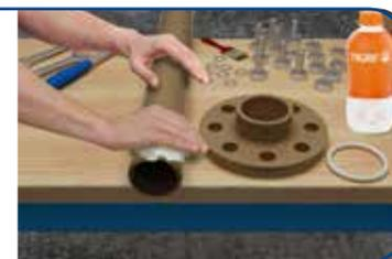
**2** Coloque la brida libre en la tubería y aplique el Adhesivo TIGRE a la bolsa de brida y la punta de la tubería.
