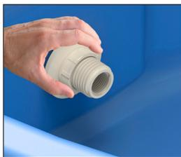
**Passo 4:** Pronto, você instalou de maneira simples e rápida o Adaptador para caixa d'água Aquatherm®, e a partir dele deve-se proceder com a ligação até a alimentação do boiler.
