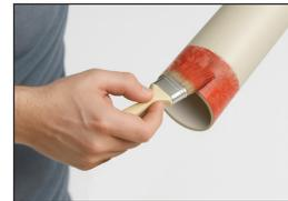
**Passo 3)** Aplique uma camada de ADESIVO PARA CPVC TIGRE na conexão:
