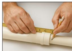
**Passo 3:** Posicione a Junta de Expansão Aquatherm® TIGRE com o pistão devidamente estendido no local onde será instalada. Faça as marcações de corte da tubulação nos locais coincidentes com o fundo das bolsas da Junta de Expansão Aquatherm® TIGRE;
