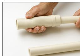
**Passo 2:** A Junta de Expansão Aquatherm® TIGRE deve ser instalada com o pistão parcialmente estendido de acordo com o cálculo do comprimento P. Faça a marcação do comprimento de acordo com a ilustração da posição do pistão;
