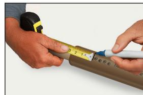
**Passo 3)** Bitolas de 20 a 50mm: Aplique uniformemente o Adesivo Plástico TIGRE na área demarcada da extremidade do tubo e na parte interna da bolsa da conexão (com o aplicador do frasco, uma trincha, ou o bico da própria bisnaga). Certifique-se que a aplicação cobriu toda a superfície a ser soldada. Evite o excesso de adesivo.
