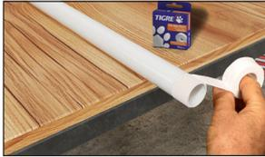
**Passo 2)** Corte a fita e pressione-a junto a rosca para garantir o perfeito acabamento; Evite deixar a sobra da fita na extremidade da ponta da rosca, pois pode dificultar a fixação;
