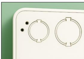
**Passo 2:** Identificando o local, pressione com firmeza a caixa contra a placa. Utilize as 4 marcas deixadas na placa como gabarito para iniciar o recorte;
