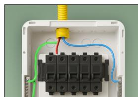
**Passo 7:** Após a instalação elétrica, fixe a moldura com a tampa no quadro de distribuição com os parafusos que o acompanham;
