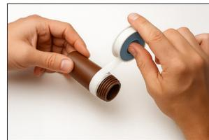
**Passo 2)** Corte a fita e pressione-a junto a rosca para garantir o perfeito acabamento; Evite deixar a sobra da fita na extremidade da ponta da rosca, pois pode dificultar a fixação.
