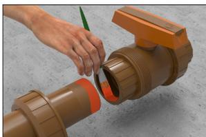
**Passo 3:** Alinhe a ponta do tubo com a bolsa do registro e encaixe de uma vez a extremidade a ser soldada, promovendo enquanto encaixar um leve movimento de rotação entre as peças de ¼ de volta até que a ponta do tubo seja inserida até o final da bolsa, observando a marcação inicialmente feita no passo 1.
