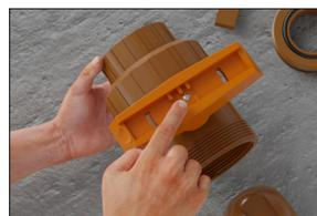
**Passo 8:** Retire o volante e a haste do corpo do registro.
