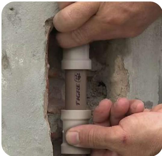
Figura 28 - Execução de reparos com Luva de Correr Soldável
