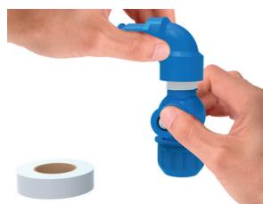
**1.** Rosquear o Registro de Entrada (peça A) no joelho (peça B) utilizando fita veda rosca, posicionando o registro conforme figura
