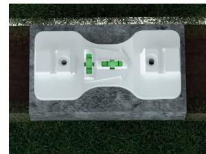
**Passo 2:** Verifique se a base rígida está nivelada utilizando como orientação os indicadores de nível existentes na base da UMC.
