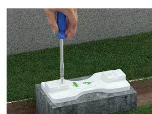
**Passo 5:** Fixe a base da UMC através dos parafusos que acompanham o produto verificando o sentido do fluxo de água através da indicação da seta em alto relevo na base da UMC. Verifique novamente o nivelamento e corrija-o se necessário. Insira nos furos as buchas S8 que acompanham o produto.
