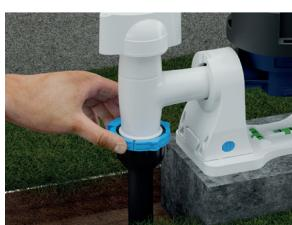
**Passo 11:** No caso do ramal predial ter sido executado com tubo de polietileno e conexão de compressão, instale o lacre tipo canaleta nesta conexão conforme a ilustração.
