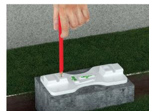
**Passo 3:** Com auxílio de um lápis ou punção faça as marcações dos furos para fixação da base da UMC.
